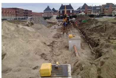
Figuur 16: Aanleg kabels en leidingen
