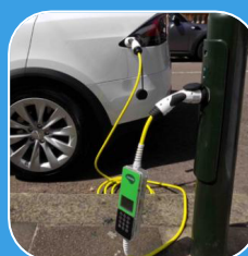
Figuur 5: Lantaampaal met laadpunt
